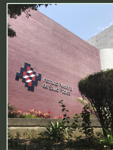
Instituto Nacional de Salud Pública Adecuaciones en sistema de ventilación
