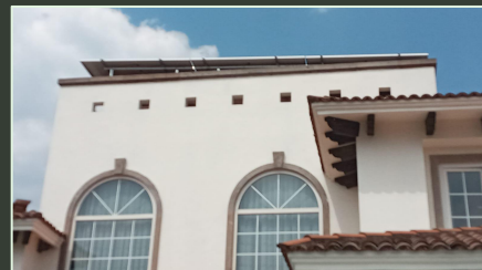
Particular Lerma, Mx Instalación de sistema solar
