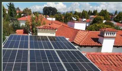
Particular Lerma, Mx Instalación de sistema solar
